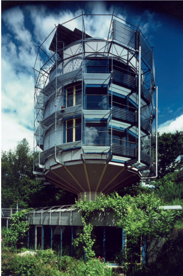
Abb. 4: Freiburg, Heliotrop, Rolf Disch, 1994
